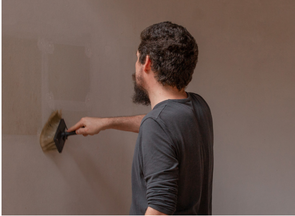
STEP 1. Clean the substrate (wall).
