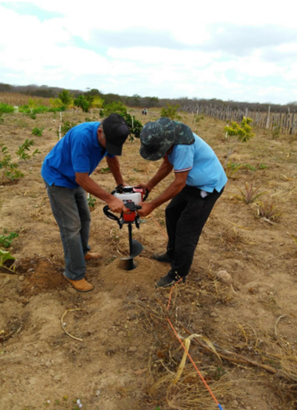
Figura 25 - Momento da implantação do SAF Bom Sucesso. Área degradada em processo de recuperação pela instalação da barragem subterrânea e do sistema agroflorestal. Perceber o remanescente de vegetação nativa ao fundo. Fonte: PROCASE (2018).
