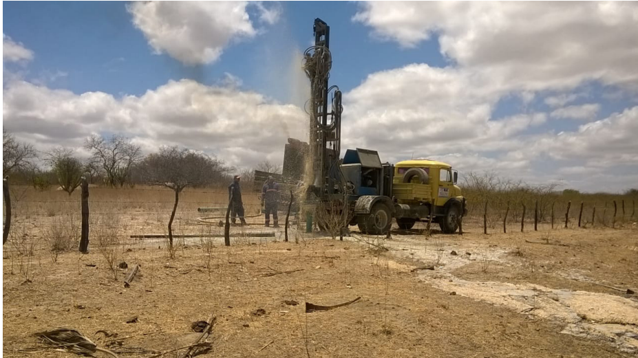
Figura 8 - Perfuração de poço em comunidade atendida pelo PROCASE. Fonte: Acervo PROCASE.
