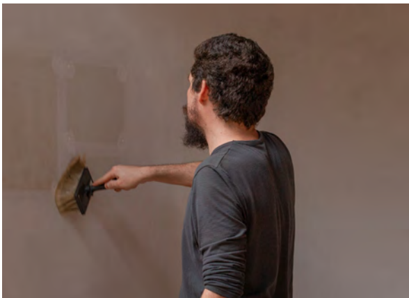
ETAPA 1. Limpar o substrato (parede).
