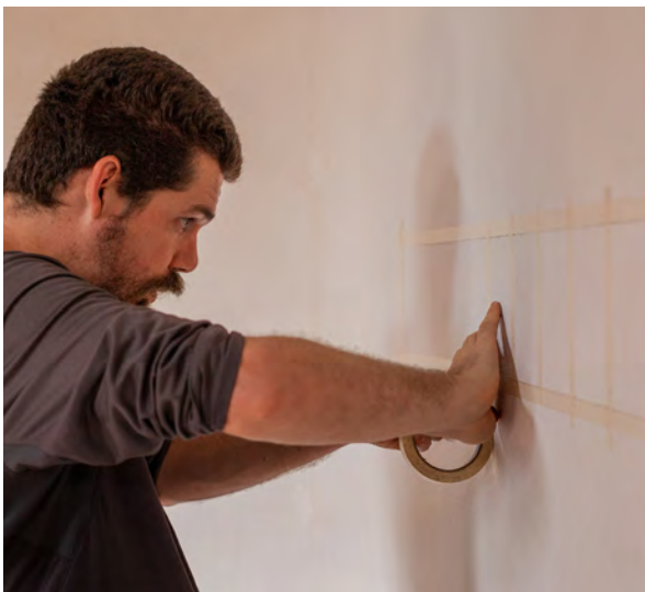
ETAPA 2. Delimitar com fita adesiva os espaços para a aplicação de cada amostra. Sugestão: marcar espaços retangulares de 10 por 15 cm para cada amostra/cor.
