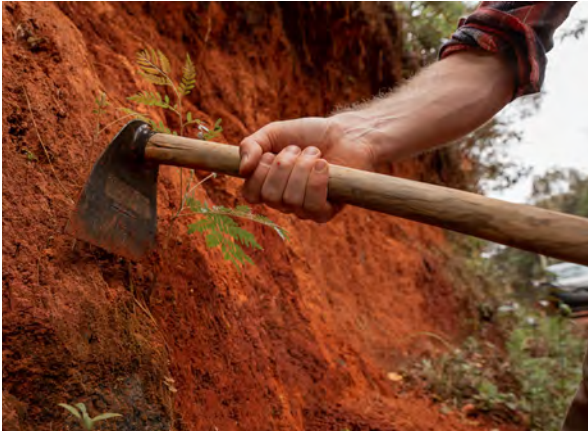
ETAPA 1. Fazer limpeza superficial do barranco.
