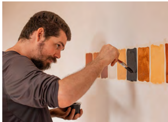
ETAPA 3. Misturar bem cada amostra e aplicar com pincel a primeira demão nos espaços delimitados, lembrando de identificar cada amostra aplicada na parede. Esperar secar (o tempo de secagem depende de vários aspectos como temperatura, umidade, ventilação, incidência solar e porosidade do substrato). Aplicar a segunda demão, esperar secar e por fim aplicar a terceira demão. Lembre-se de sempre misturar bem antes de pintar.
