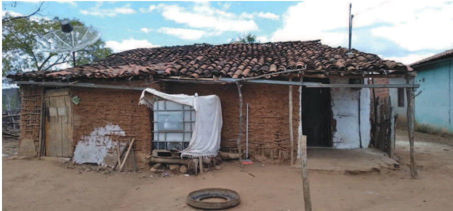
Figura 11. Casa de taipa com telha de cerâmica em Quixaba, Irauçuba
